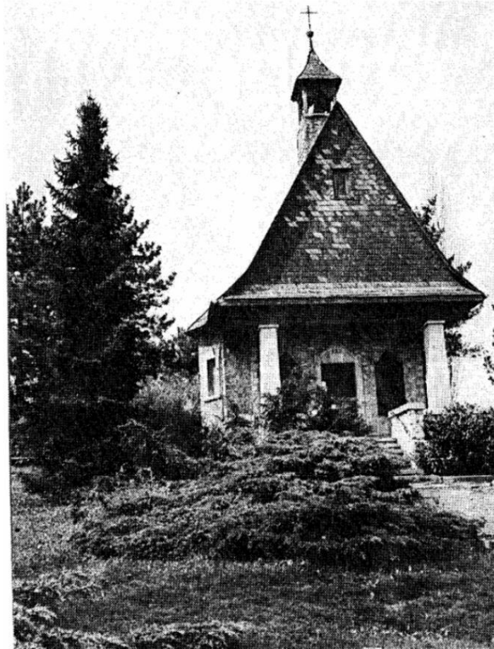
Die Renovierung der Kapelle kostet 60 000 Mark. Etwa die Hälfte davon haben die „Rabenkatzen“ schon zusammengetragen. Bild: Etzelsberg
